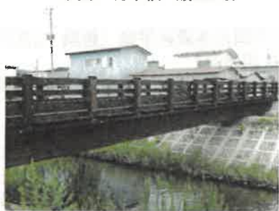
写真2 中川原2号橋（能代市）
