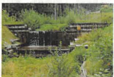
写真3 木製治山ダム（北秋田市）
