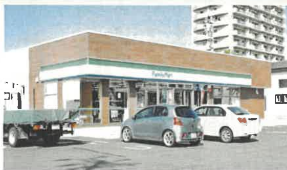
写真1 県産スギのツーバイフォー製材トラスを用いたコンビニ店舗
