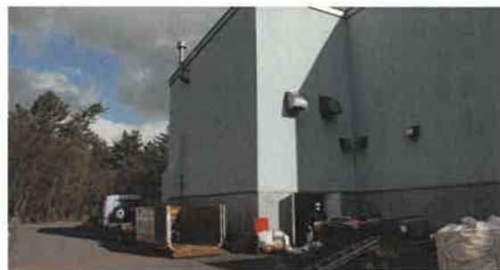
増築工事箇所の現在の様子 （目下、既設物の撤去作業中）
