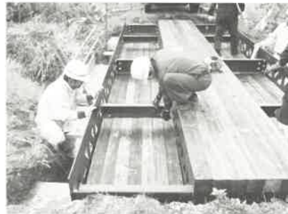
三種町での木橋架設の実証試験
