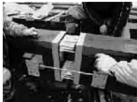
写真2 施工現場での接着接合作業
