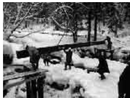
写真3 橋桁の架設
