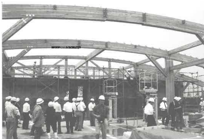
建設工事の中の本館棟（1995年）
