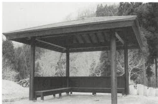
【写真4】 スギ樹皮ボードを使用したあずま屋
