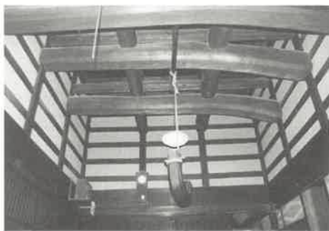
写真1 大きな吹き抜け空間を固める「サシモン」造り (石川県能登地方)
