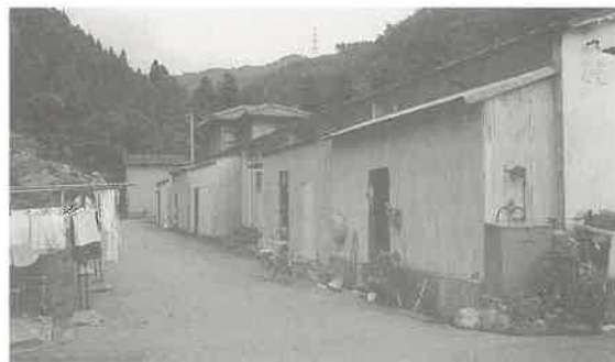
写真4 塩ビの波板で後付けした公営住宅の雪囲い（石川県鳥越村）
