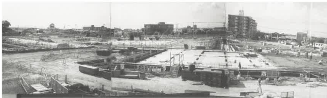
木材加工研究センター建築現場
