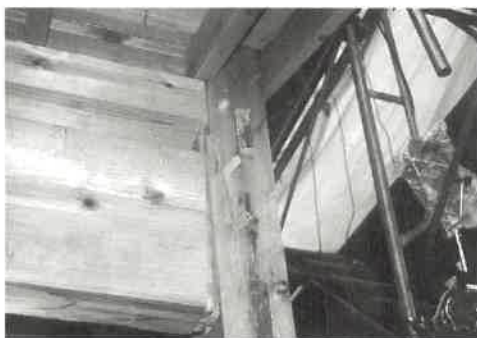
写真4：伝統型C棟の最終破壊状況。 本屋1階隅の独立通し柱頭部に縦割裂が生じ、指物が引き抜け。
