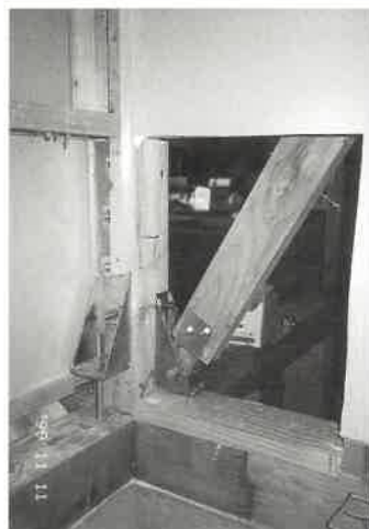
写真5：在来型A棟の修復状況。ホールダウリ金物によって柱を基礎へ直接縫い付け。筋かい端部へステンレス接合金物を挿入。
