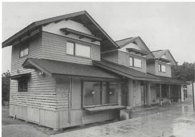
写真7：3棟の実験棟の現況。2階の外装までの工事が完了。 B、C棟間に円筒LVL柱が立つ玄関部分を増築。 A、B棟間の下屋を繋ぎ、雪国特有の「土縁」の設置を予定。
