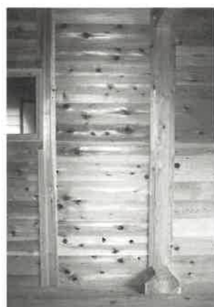
写真6：伝統型C棟の修復状況。 添木により柱に縫い付けられた落とし板壁。
