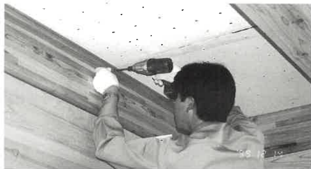
写真2 スギ樹皮天井ボード施工風景
