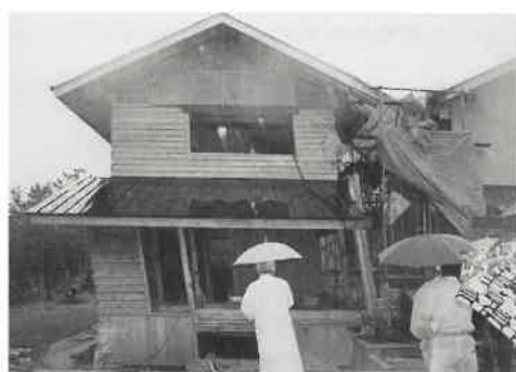
写真2: 大加力時の伝統型C棟の変形状況。壁土は剥落するが、軸組がしなやかに大変形を吸収。
