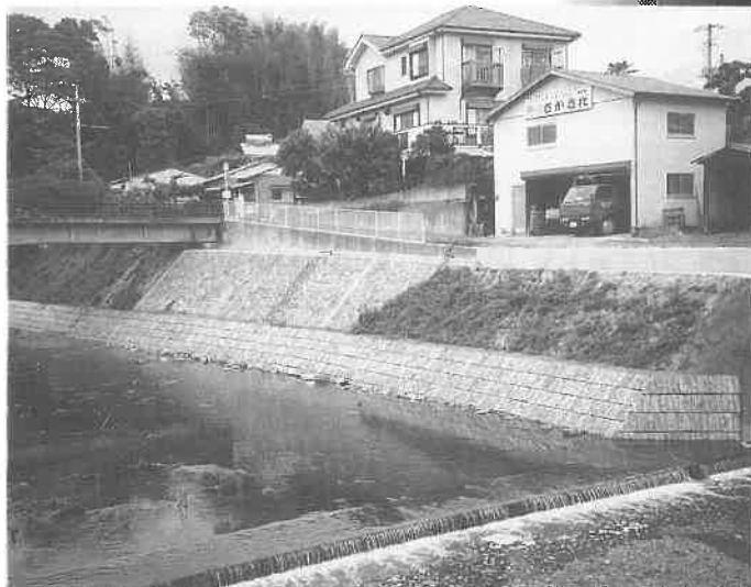
既設護岸工化粧材に使われている木質材料（神奈川県中村川）
