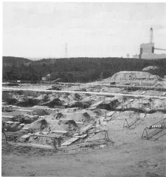
写真 建築工事が進む研究所 （本館研修棟）
