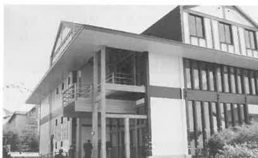
（写真7. 新装の木造実験棟）
