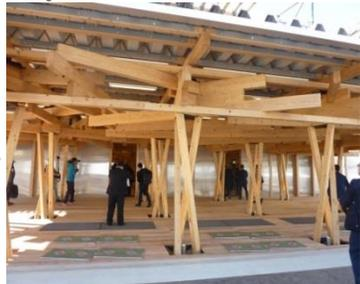
秋田スギは玄関棟の梁のほか、柱、床、壁に構造用合板やCLT(3層3プライ)なども見えます。外構で使われるフェンス材も含めると供給量は23.9<sup>メートル</sup>に達するとのこと。
