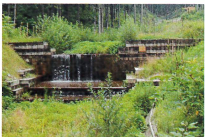
写真3 木製治山ダム（北秋田市）
