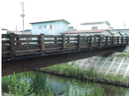
写真2 中川原2号橋（能代市）
