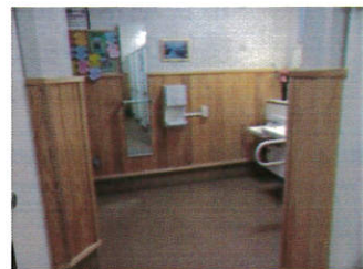
写真5 内装を木質化した山形自動車道櫛引PAのトイレ
