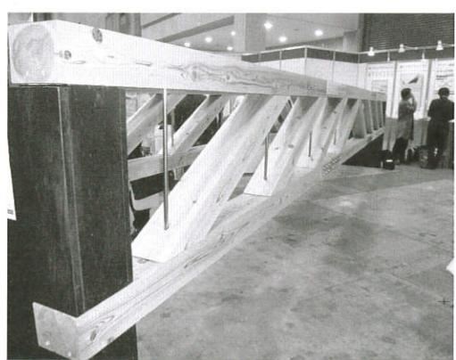
発信、人材育成、ネットワーク化をキーワードとした出展を行った。各種セミナーと活動内容のポスター展示、若い大工職人による継手・仕口の加工実演と指導などを公開したほか、規定寸法材で大スパン(8㍍)を飛ばす複合ハイブリッド梁や国産材による構造用耐力壁なども展示、在来工法の技術で大型の木造建築物に挑戦していく構えを見せていた。
