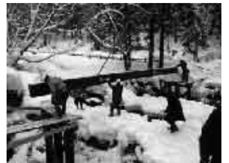
写真3 橋桁の架設
