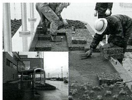
写真-2 伐根多孔質成形体の施工実験
