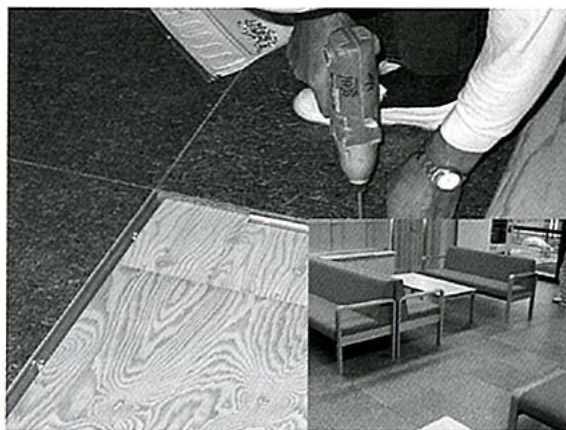
写真-1 伐根パーティクルボードの施工実験
