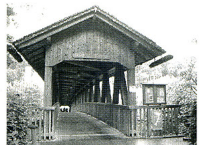
写真6 ミュンヘン市近郊の屋根付き木橋
