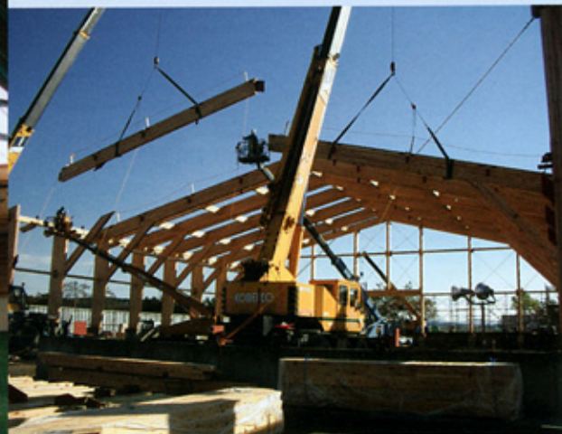
梁の組み立て(H15.10)▲
