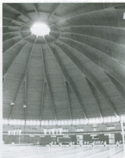
写真3 大断面集成材を使用した市民プール。 25m・7コースのプールを内部にもつ立派な構造物。
