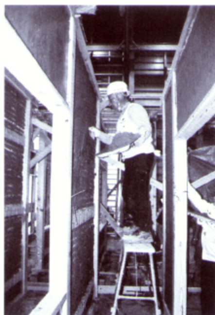
写真7. 木小舞と藁貫伏せの秋田型土壁の製作風景
