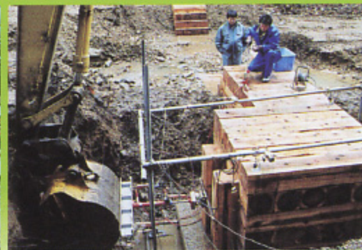
施工現場での安定性の確認試験(比内町)
