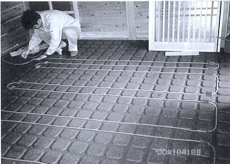
【写真2】スギ樹皮成形ボードによる床暖房の施工 (能代市S邸)
