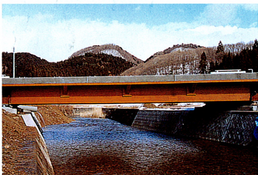
林道母体橋（高欄取付前 3月7日撮影）
