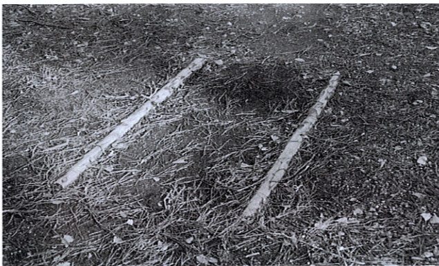
【写真2】 舗装用スギ樹皮ボードの耐久性 (3年経過後の状況)
