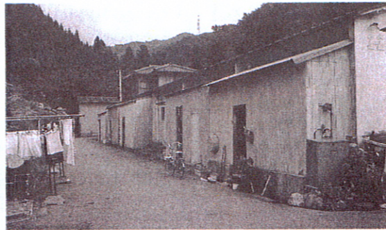
写真4 塩ビの波板で後付けした公営住宅の雪囲い (石川県鳥越村)
