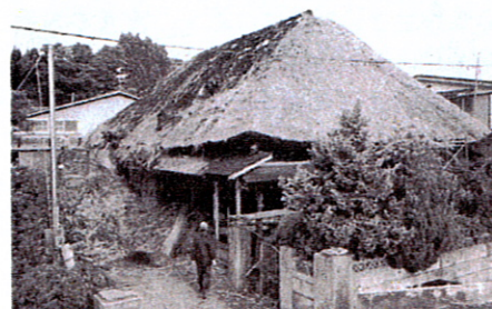
写真16 茅葺き屋根をほぐす「結」の共同作業 (秋田県二ツ井町)
