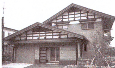
写真17 地場の材と地場の職人の手で造られた 秋田型伝統的構法の家 (秋田県秋田市)
