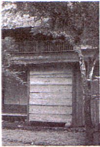
端板 (新潟県小千谷市)
