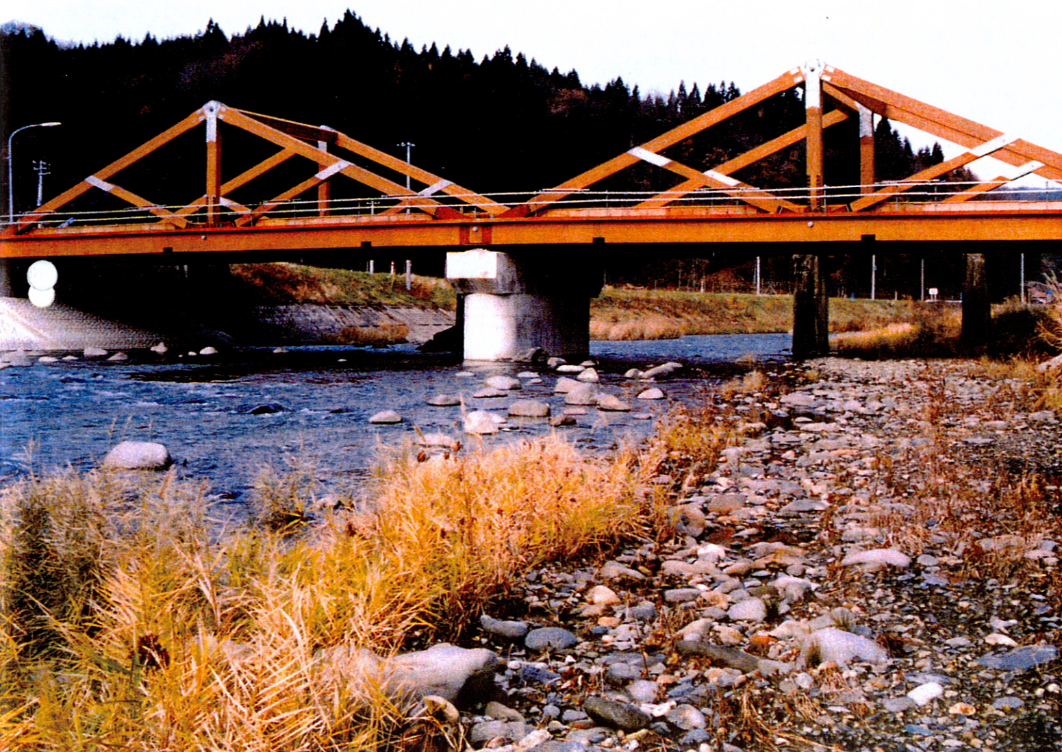
藤琴川に架かる完成間近な木橋「坊中橋」 (12.11.24撮影)
