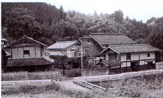
平成12年鳥取県西部地震の激震地であって無被害の伝統民家（鳥取県日野町）
