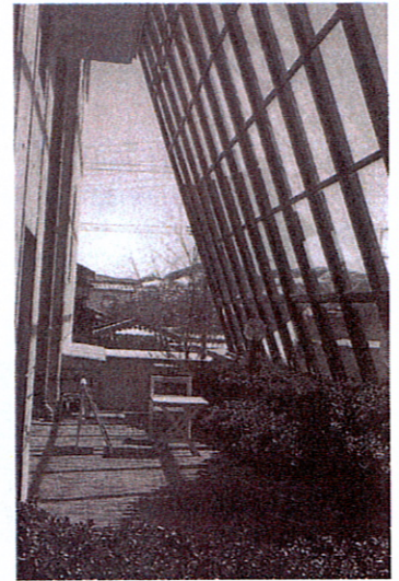
写真5 鉄とガラスを使った現代コンクリート住宅の雪囲い (石川県野々市町)
