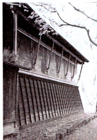
写真2 武家屋敷の蔵の深い軒を支える方杖（秋田県角館町）
