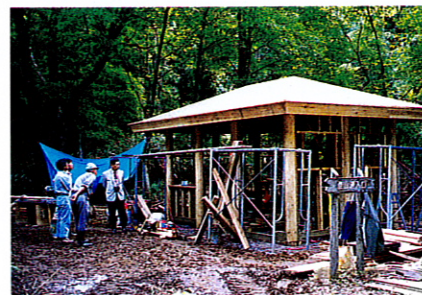
【写真3】作業小屋の屋根下地材として利用
