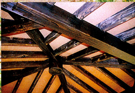
東屋の屋根下地材 (樹皮ボード)
