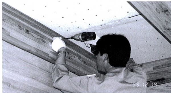
写真2 スギ樹皮天井ボード施工風景
