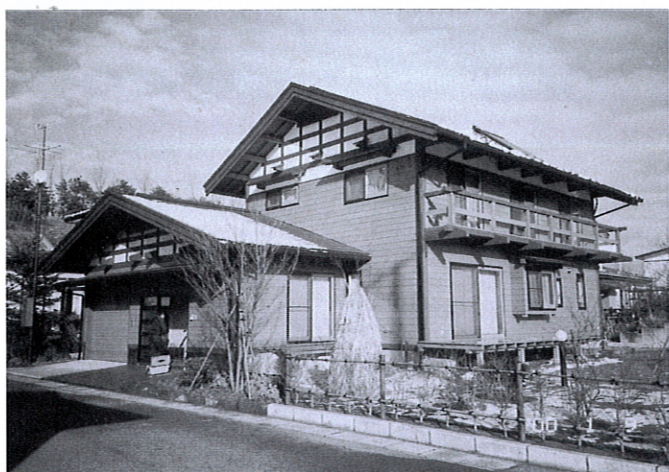
写真8：耐震実験の成果を生かして建設された伝統型軸組構法の木造住宅。地場産の材と技によるエコロジーな住まい（秋田市追分）。
