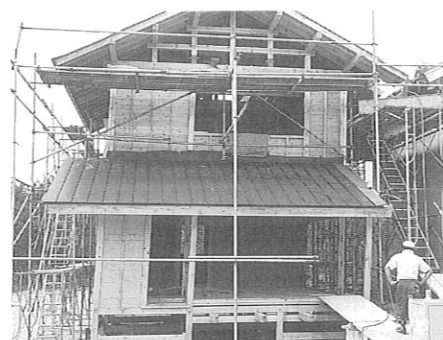
写真8 大変形にも粘り強く振る舞う伝統的構法のC棟
