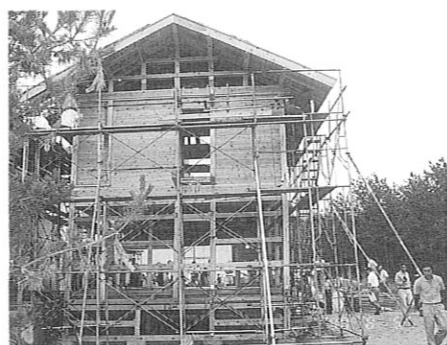
写真1 C棟第1回公開実験の様子
