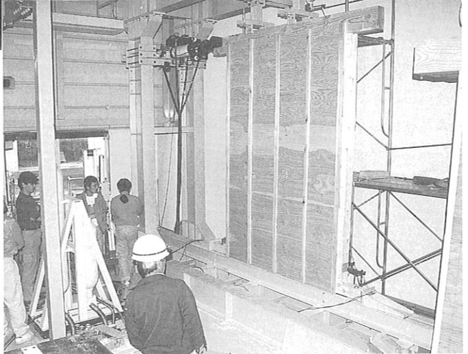
依頼試験（壁パネル耐力試験）
