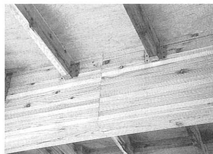
木製ダボで接合された集成材の梁
