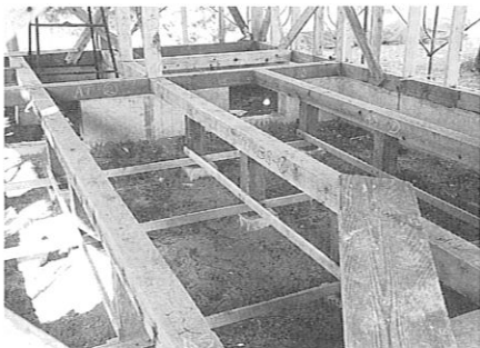
在来軸組の布基礎と防腐土台
