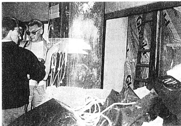
ノルウェー オスロ裁判所のナミダタケ被害をヒーターの熱で駆除している
