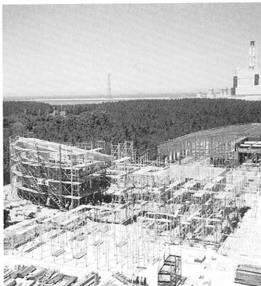
○手前が本館研修棟
