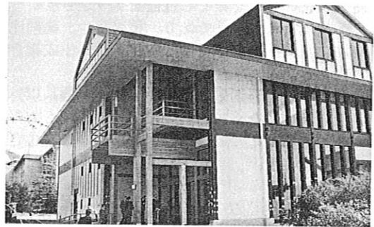
(写真7. 新装の木造実験棟)
