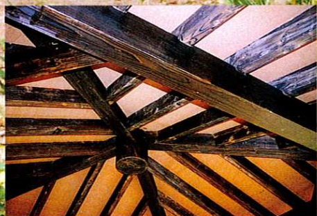
東屋の屋根下地材 (樹皮ボード)
