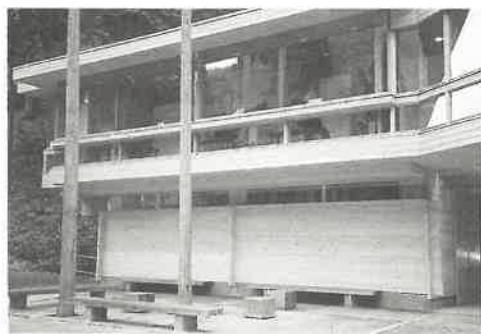
【写真1】檜田温泉 2階 浴室 1階 ボイラー室及びペレット収蔵庫
