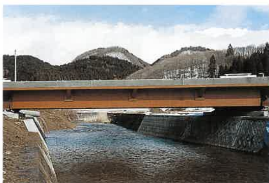
林道母体橋（高欄取付前 3月7日撮影）
